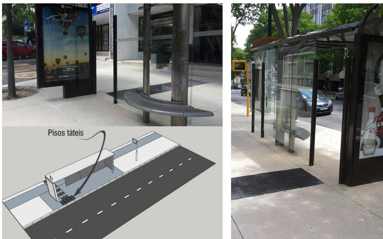
Paragem de Autocarro na Rua Alexandre Herculano (Lisboa), tornada acessível com as seguintes adaptações: (1) plataforma com dimensão suficiente para entradas e saídas, (2) lancil na zona de acostagem com altura de 15 cm para facilitar uso da rampa, (3) piso liso para prevenir quedas e facilitar limpeza, (4) guia no passeio para apoio aos passageiros com deficiência visual e (5) abertura para entrada na face posterior do abrigo (porque a árvore impede o acesso lateral)
