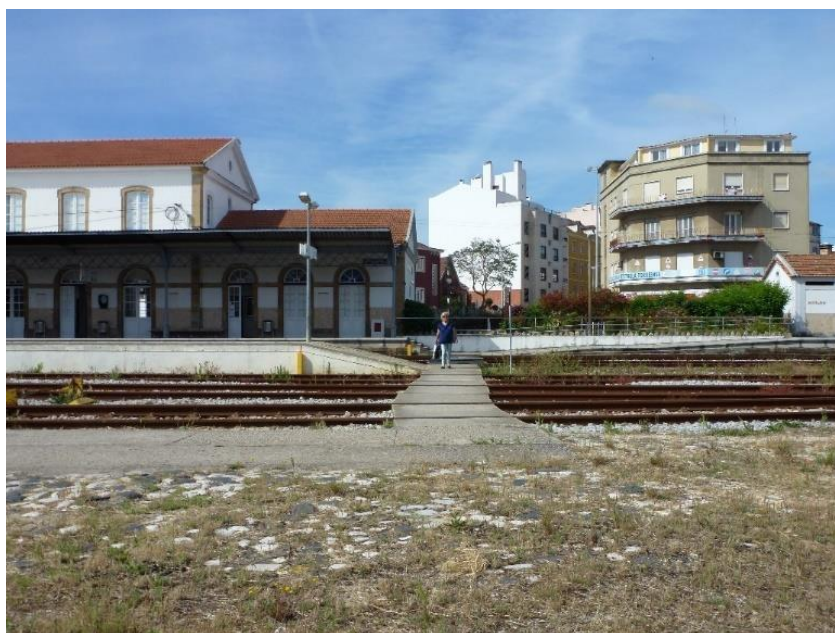
Atravessamento pedonal da linha de caminho-de-ferro
